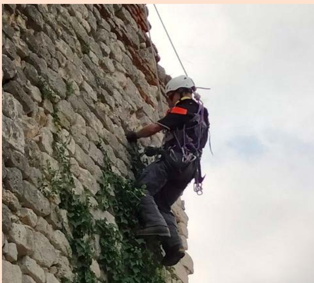
Fra i compiti della squadra alpinistica c'è anche la messa in sicurezza dei muraglioni.
