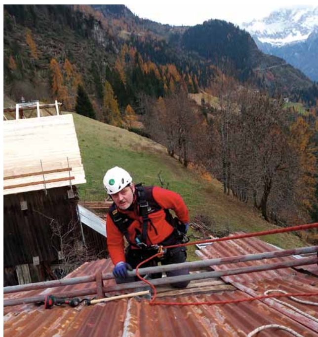
Si sistema il tetto di una casa a Rocca Pietore
