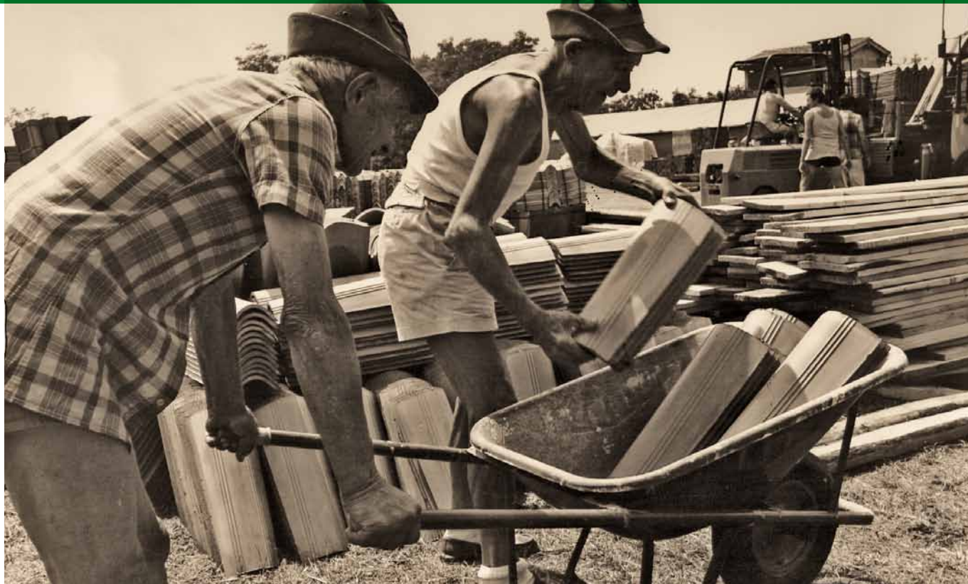
Arturo Carta e Giacomo Bassanese, reduci del Btg. Monte Berico, lavorano nel cantiere di Artegna per la ricostruzione. (foto Archivio Ana)
