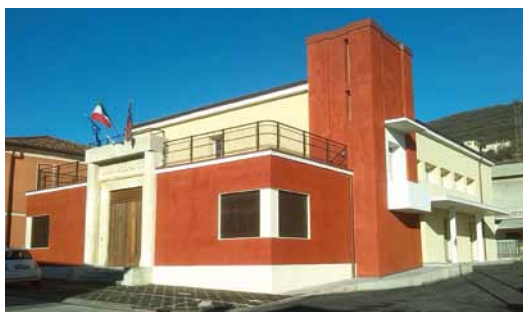
L'ex Casa del Fascio di Barbarano, ristrutturata dal Comune.
