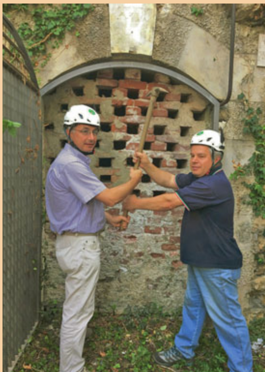
Il sindaco Valter Orsi e il capo squadra Danilo Zambon abbattano il muro d'ingresso al rifugio
